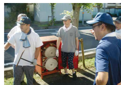
ホース格納箱の確認
