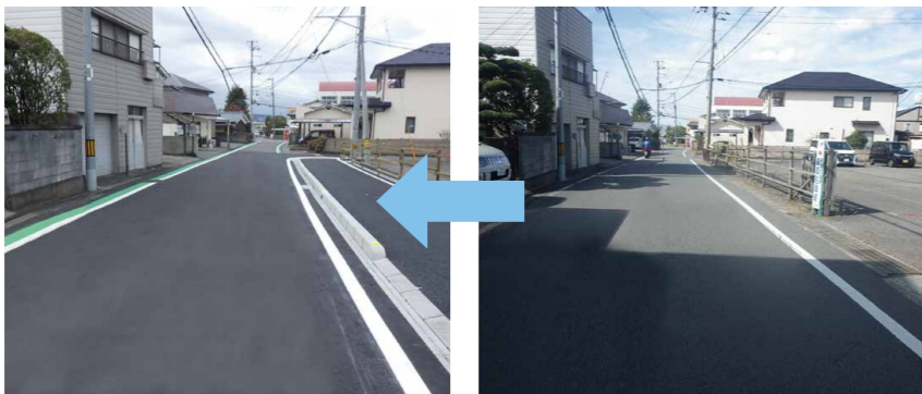
旧重信町役場跡地南側道路 歩道整備
