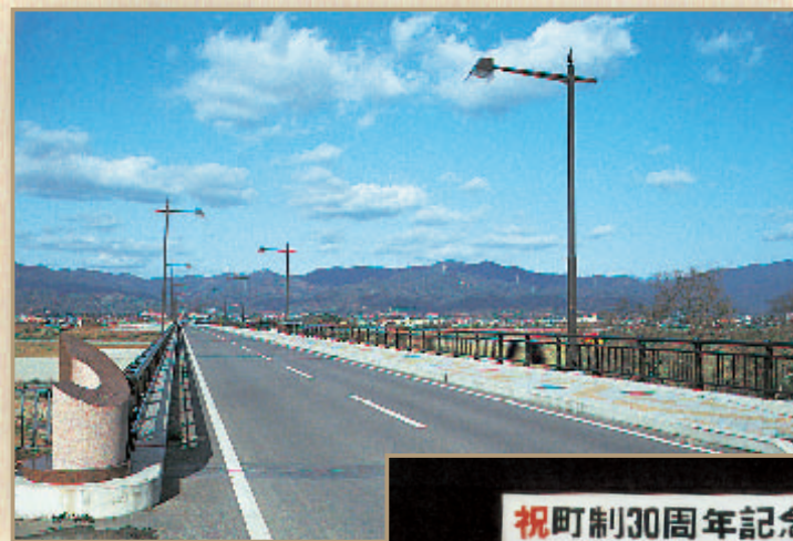
上村大橋完成
