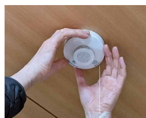
住宅用火災警報器の設置
