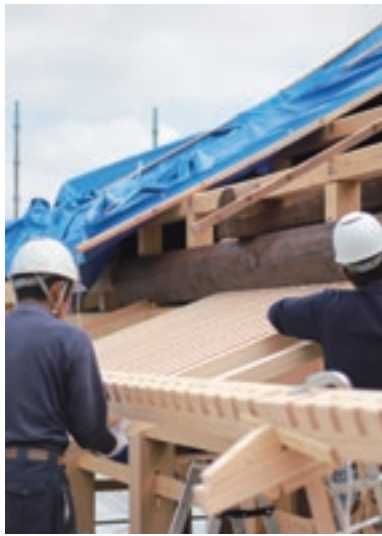
丸桁に垂木を一つひとつ手作業で差し込む。
