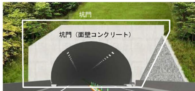
図-7.2 点検対象箇所（トンネル坑口部）
