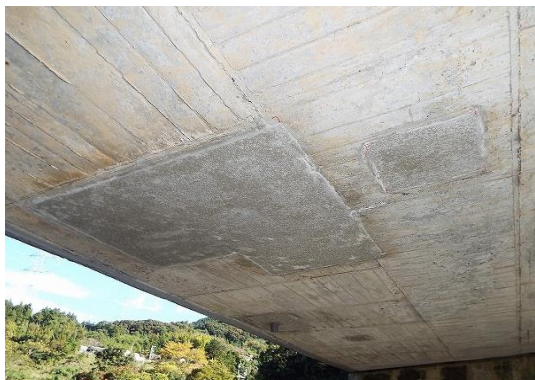
図 8 コンクリート補修
