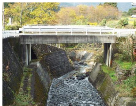
図 2 松本橋（橋長 12.9m）
