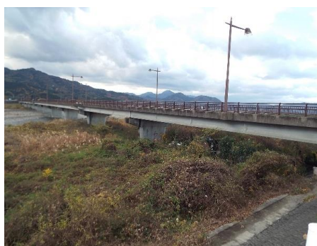
図 1 上村大橋（橋長 500.0m）
