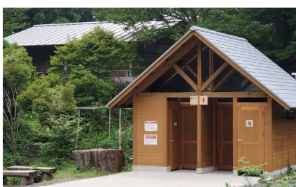
風穴前のトイレと避難小屋(奥)
