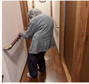
転倒予防の手すり
