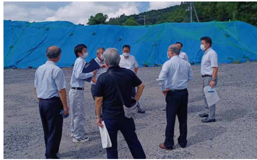
盛土材置き場
