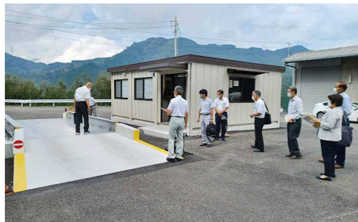
事務所と雨水が侵入しない計量器
