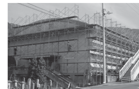
耐震工事に取った上林小学校 体育館
