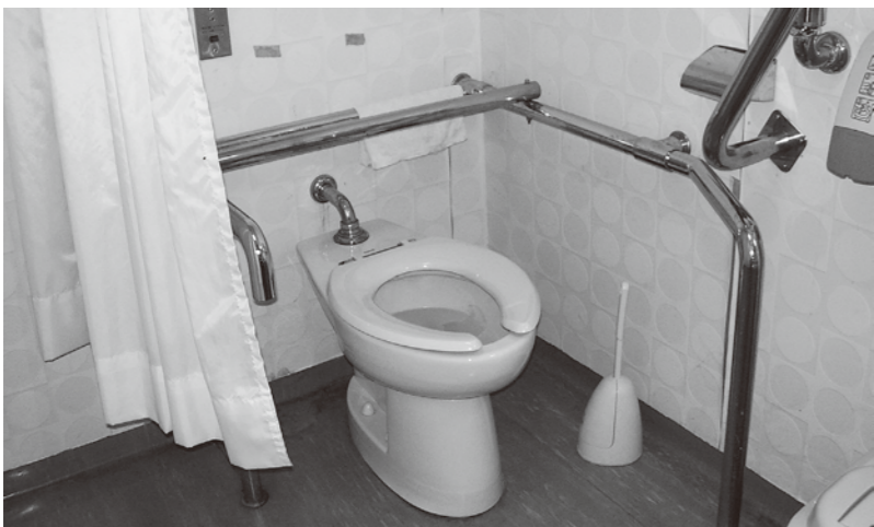
中央公民館の障害者用トイレ
