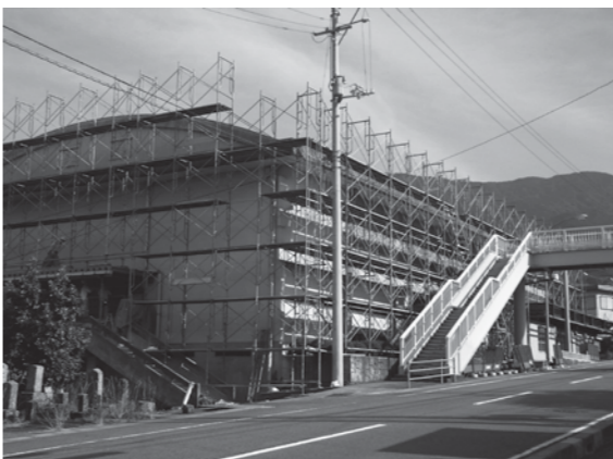
耐震工事が進む学校施設
