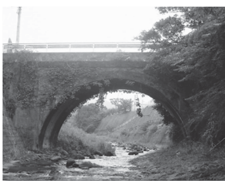
橋長15mを超える橋の中で市内で最も古い大正10年に架けられた三和橋（JAえひめ中央三内支所近く）
