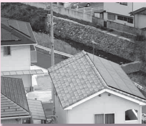
民家の屋根に設置された太陽光発電パネル
