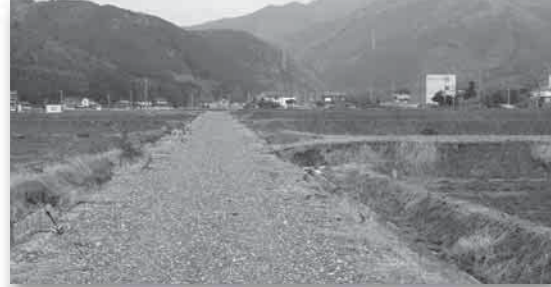
樋口地区 土地改良事業
