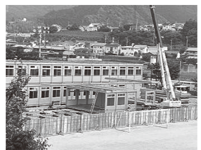
仮設校舎の建設が進む川内中学校
