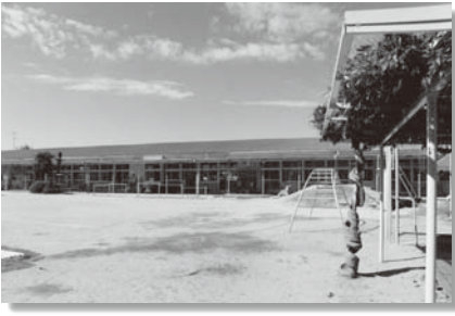
耐震改修される南吉井保育所
