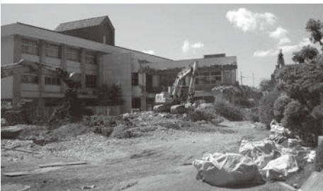
工事中の川内中学校
