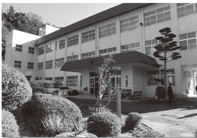
耐震補強工事が予定されている西谷小学校
