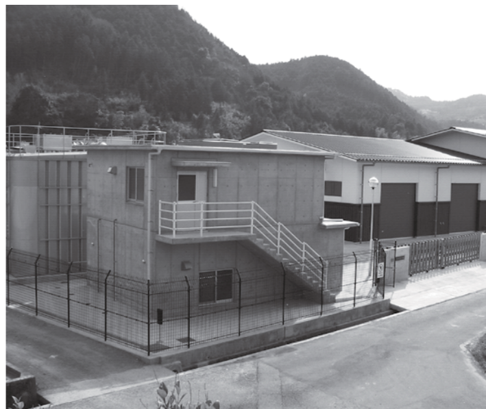
平成22年度に完成した川内浄水場
