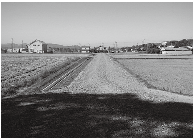
志津川地区ほ場整備
