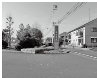
愛媛病院西側の市道10号線
