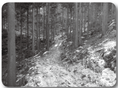
作業道の整備状況
