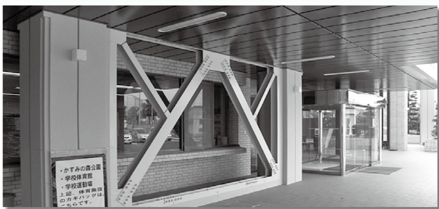
耐震工事が終了した中央公民館
