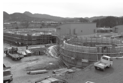
増設中の下水道終末処理場
