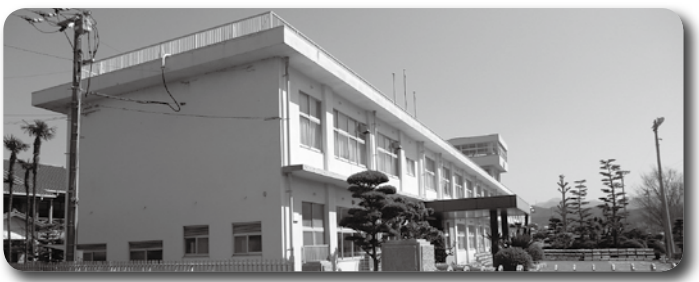
耐震補強工事を行う川上小学校南校舎
