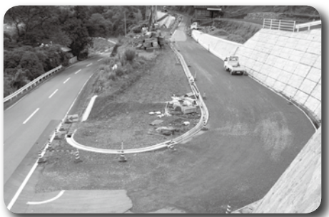
8月末完成予定の市道日浦線改良工事
