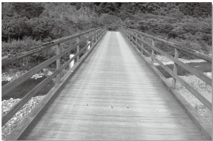
転落防止柵取替工事を行う御所橋(山之内)
