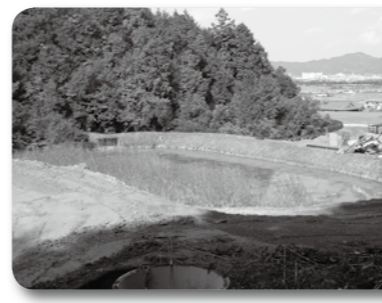
阿弥陀池改修工事(上村)
