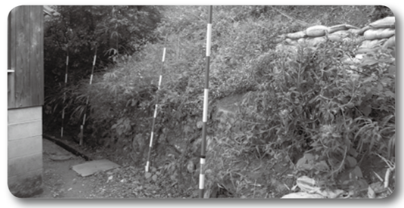
がけ崩れ防災対策現場
