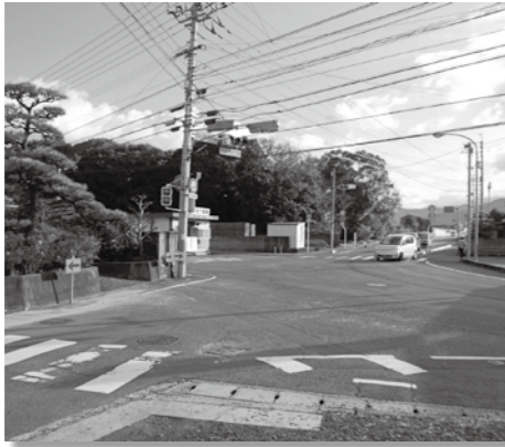
改良予定の交差点現場
