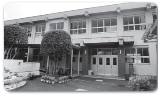
耐震補強改修工事を行う東谷小学校
