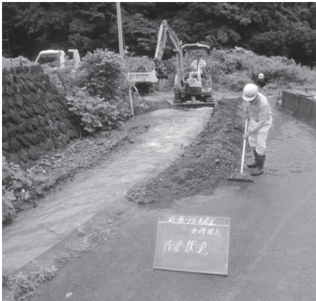
地元業者による災害崩土除去作業
