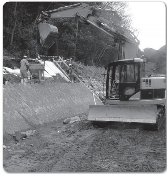
台風による道路災害復旧工事現場
