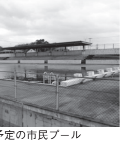
解体予定の市民プール
