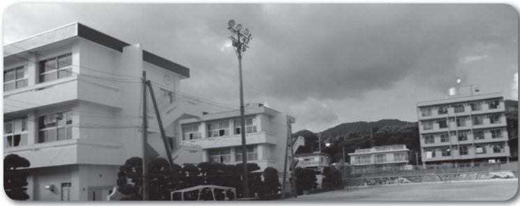
改修予定の学校運動場夜間照明
