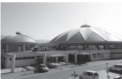
9月より改修工事予定のツインドーム重信
