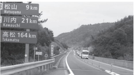
松山自動車道の伊予インターから松山方面7.5kmは、伊予断層(活断層)と交差をくり返して伸びている。
