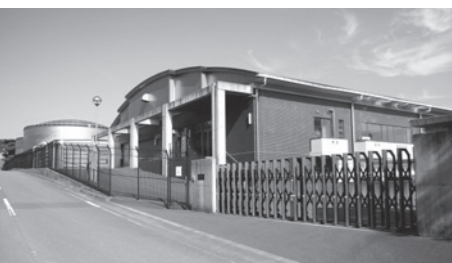
南吉井浄水場事務所スペースの有効活用を検討すべき
