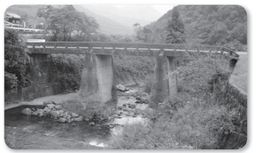
補強予定の惣田谷橋
