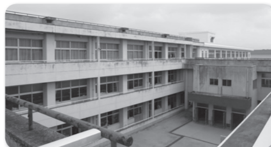
耐震補強が行われる南吉井小学校北校舎西棟
