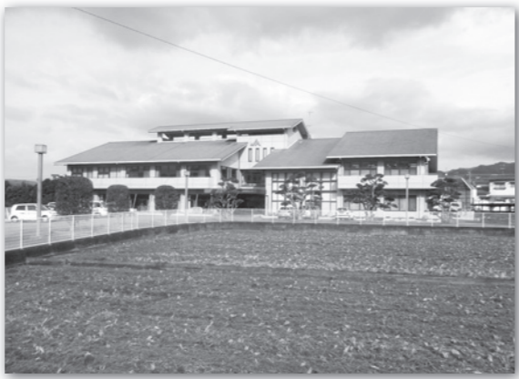
目的外使用となっていた市社会福祉協議会が入居する農村環境改善センター
