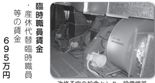
改修予定の給食センター設備機器
