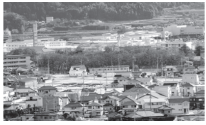
新自治区設立の検討の進む志津川土地区画整理事業地区
