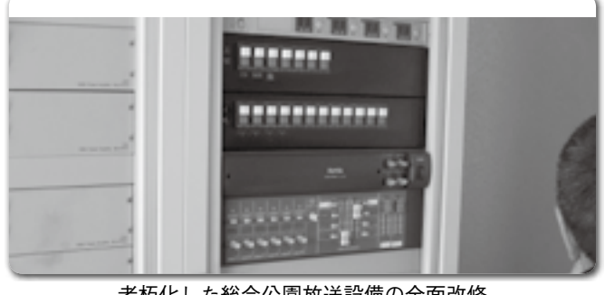
老朽化した総合公園放送設備の全面改修
