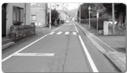
拡幅改良予定の横河原10号線(愛媛病院前の市道)
