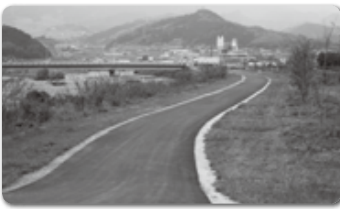
整備が進む重信川遊歩道
