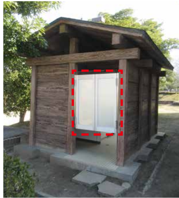
北野田区 ゆるぎ公園 男性用トイレ入り口扉
