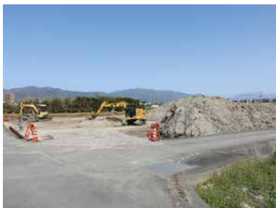
南吉井地区ほ場整備(北野田工区)
