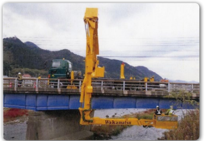
橋梁点検車による橋梁点検状況
