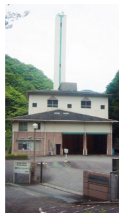
東温市クリーンセンター
