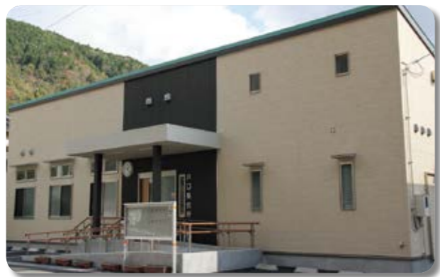
平成27年度に同事業で建築した井口集会所
