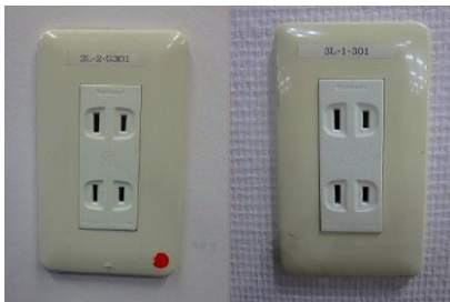
<現状：左が非常用コンセント>
