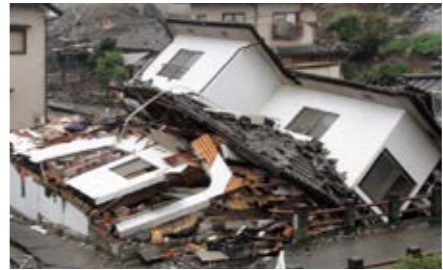
熊本地震で倒壊した家屋
