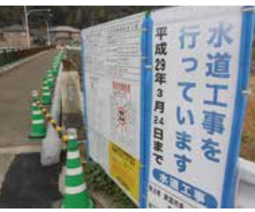
水道工事の現場
