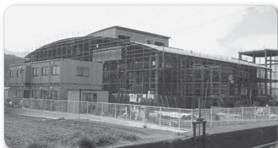
建設中の学校給食センター
