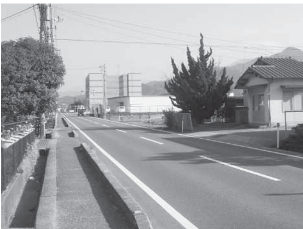
交番前 下水道工事区間
