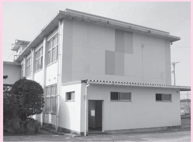
拝志小学校 北校舎トイレ
