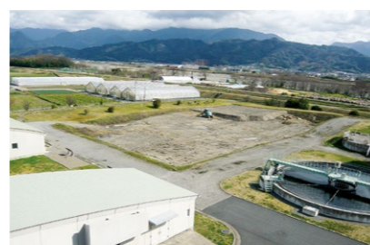
重信浄化センター
