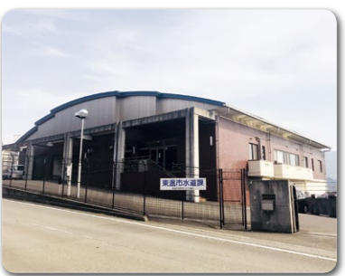
南吉井浄水場
