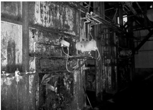
屋根は破れ、機械は腐食し、スラブは水が溜って大変
