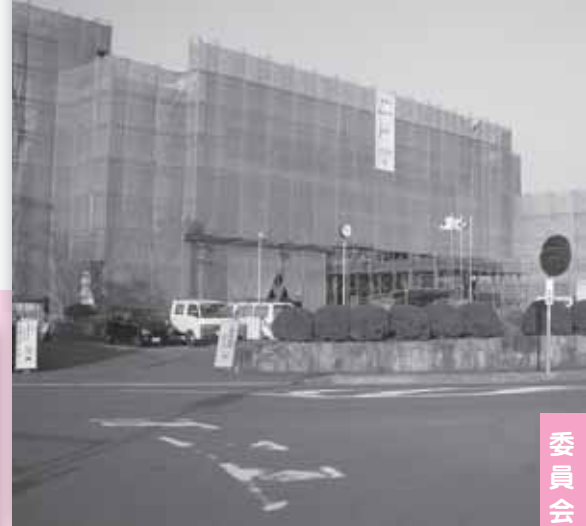
改修中の川内公民館
