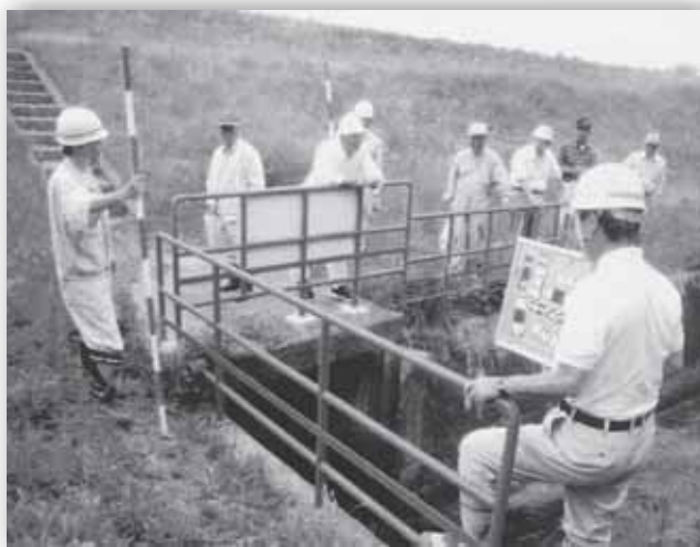
柳原堀貫水門改修
