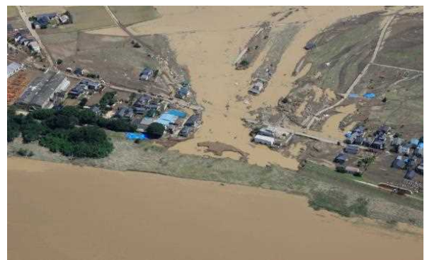
堤防決壊による家屋の流失(鬼怒川)
