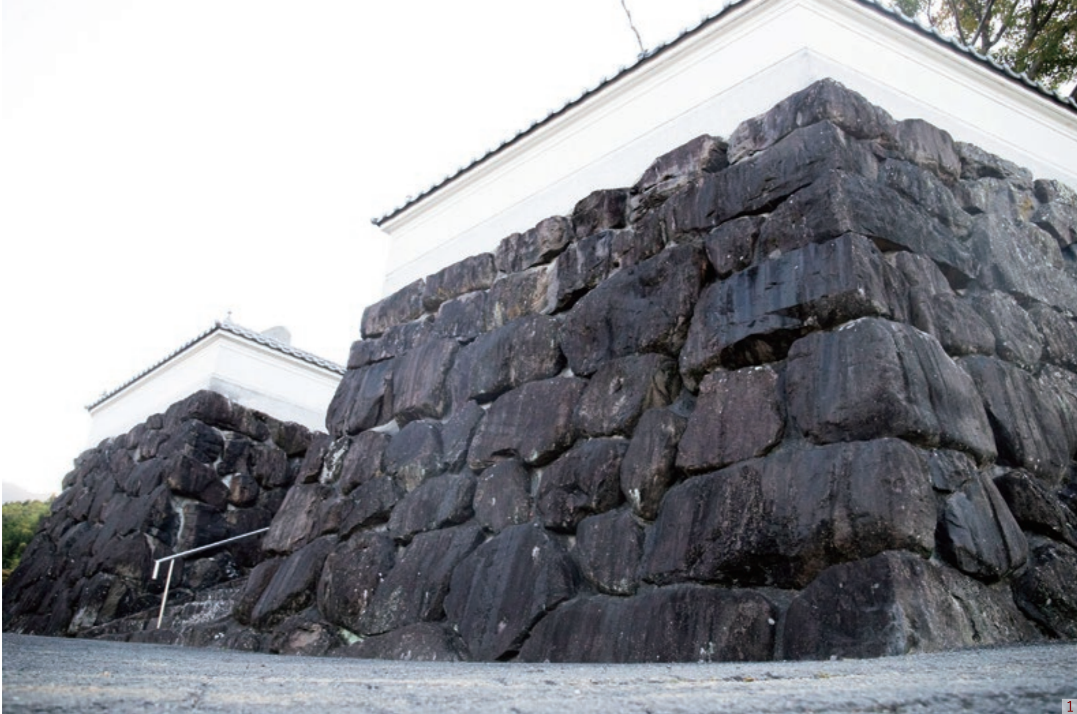
1_ 地元上林の法蓮寺の石垣は宇吉さんの弟子によって作られた。大きな石が今でも崩れることなく組み立てられている
