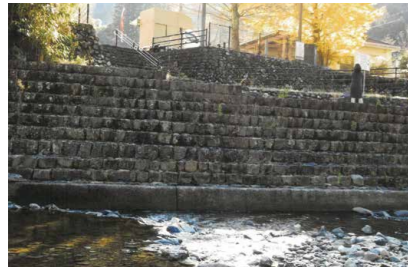
滑川から見上げる野外活動研修施設
