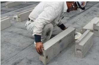
位置決めが完了したブロックを少し持ち上げ、別紙の**ボンド施工手順書**通りにボンドを塗布して下さい。
