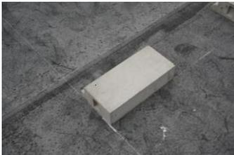
架台の設置始め基準点を墨出します。
