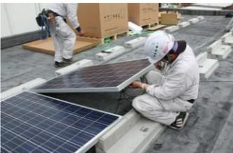
配線を上下ブロック間に這わしてから、パネルを設置します。
