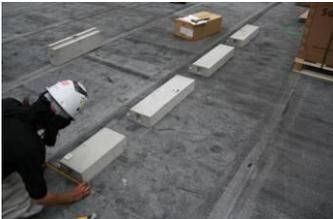
墨に合わせ、ずれない様に架台ブロックを置いていきます。
