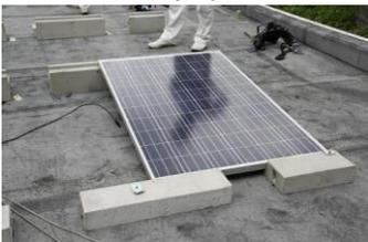
架台設置後、パネルを仮置きし、上下架台とパネルの間に隙間が出来ないか確認します。
