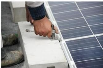
押さえ金具をモジュールフレームを確実に押さえられる位置でボルト留めて下さい。
