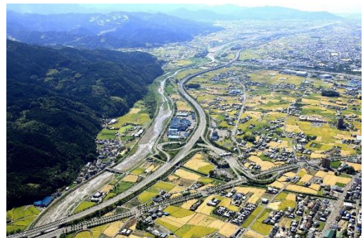
川内インターチェンジ
