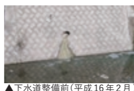
▲下水道整備前(平成16年2月)
