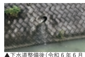
▲下水道整備後(令和6年6月)
