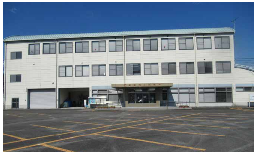
災害時に業務を維持すべき施設 川内支所
