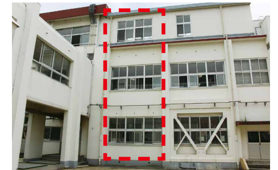
北吉井小学校のエレベーター設置予定箇所
