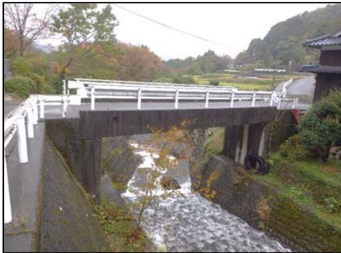
図 1 松本橋 (橋長 12.9m)
