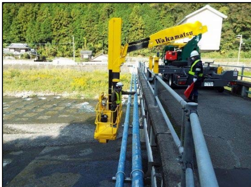
図 6 点検状況写真（橋梁点検車）
