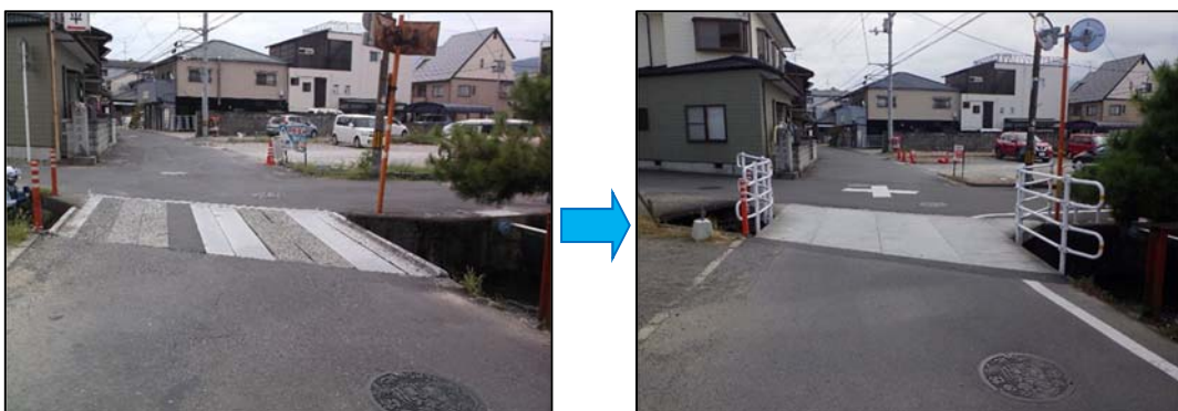
図 13 更新及び防護柵設置（横河原 1 号線 1 号橋）
