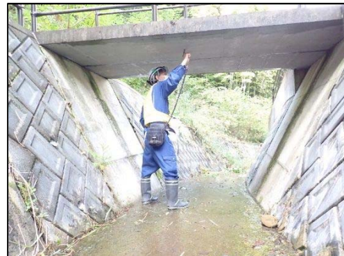
図 7 点検状況写真（地上点検）
