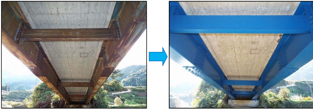
図 11 塗装塗替え（馬渡り橋）
