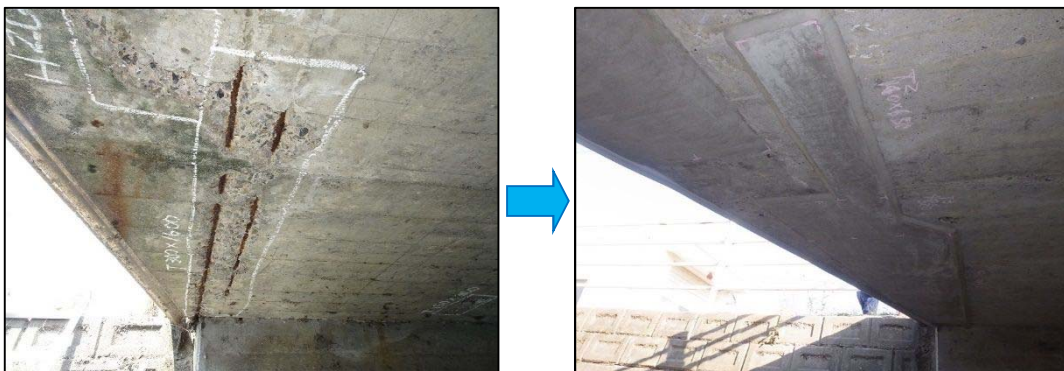
図 12 コンクリート補修（床版橋）
