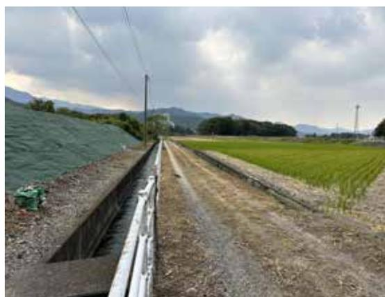
写真3-88 本堤と控堤の間の遊水地
