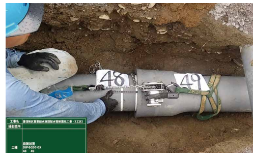
耐震化のための配水管接続工事
